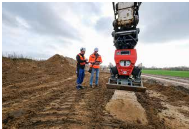
Foto: Güteschutz Kanalbau
