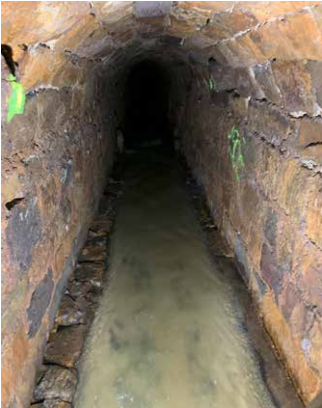
Im Rahmen einer Begehung überprüfte die Sanierungstechnik Dommel vor der Sanierung die Maße des Altbestands.
