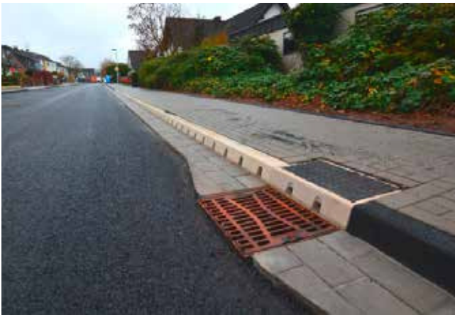
Einbau der ACO Drain@Box in der Schützenstraße, Stadt Hennef.
