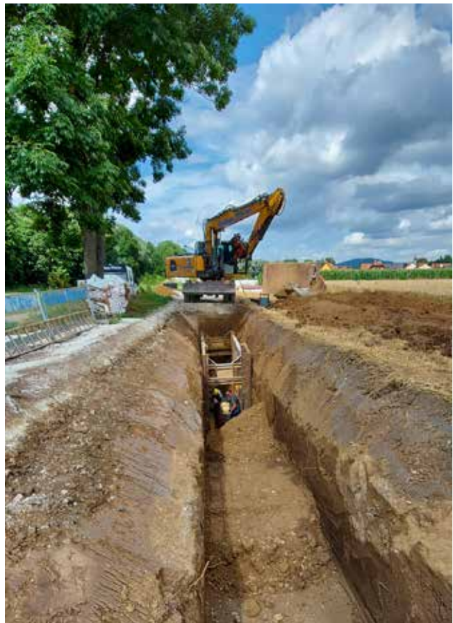
2,8 km lang ist der neue Verbundkanal, der nach seiner Fertigstellung die Abwasseranlage Scheßlitz mit der Zentralkläranlage Giech verbindet.
