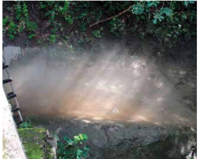
Bei dem Hochdruckspülverfahren werden Kanalrohre von Schmutz und Ablagerungen befreit. Die Reinigungsdüse am Ende des Schlauches säubert die Kanalwände zuverlässig.
