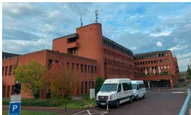
Anlässlich der Markteinführung im September 2021 wurde CAMUR III erfolgreich im Rahmen von partiellen Instandsetzungsarbeiten an der Tiefgarage des Landratsamtes in Hofheim am Taunus implementiert. Quelle: Protector KKS GmbH
