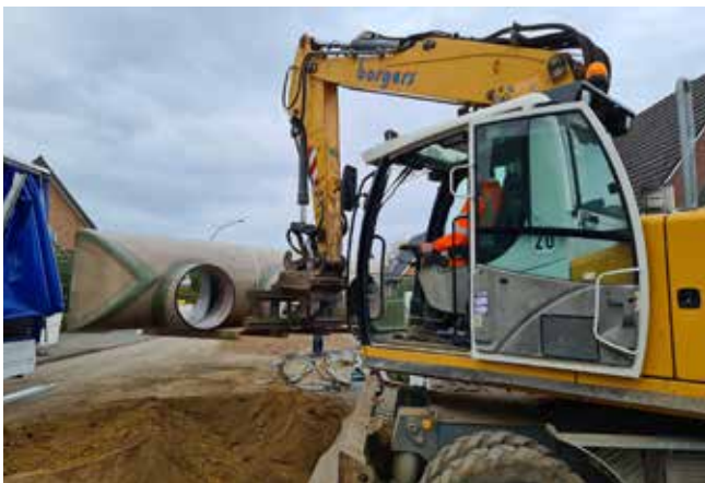
Die GFK-Produkte lassen sich ganz einfach mit dem Bagger bewegen, was Platz spart und sich auch positiv auf die Transport- und Verlegekosten auswirkt. Hier: Das Verbindungsbauwerk als Sonderanfertigung. Foto: Amiblu
