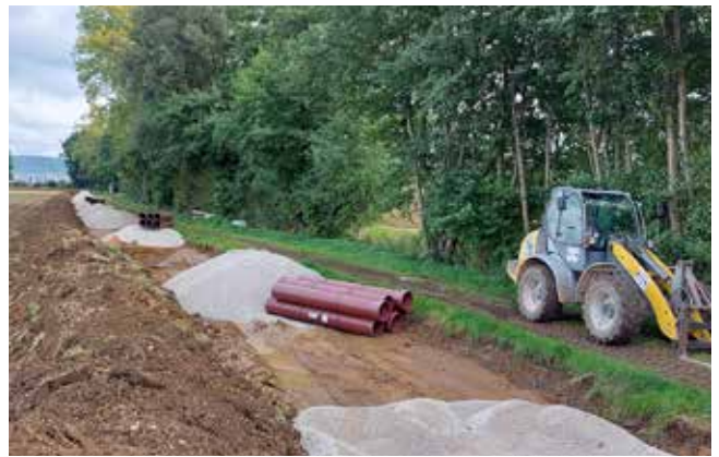
Rohre und Bettungsmaterial wurden vorab entlang der Leitungstrasse gelagert. Das hat zu einem reibungslosen und schnellen Baufortschritt beigetragen. Foto: Funke Kunststoffe
