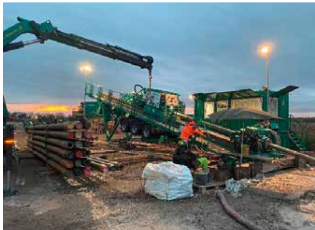
Abb. 2: Baustelleneinrichtung für die Großbohranlage, Platzbedarf mit Lagerkapazität 2.500 m 2 MIDEWA GmbH, Merseburg
