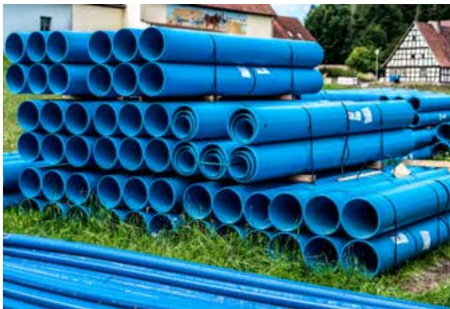
Die blaue Farbe verrät bereits den Anwendungsbereich: Mit den HS®-Kanalrohren wurden Regenwasserkanäle in verschiedenen Gemeindeteilen von Leutershausen erneuert.
