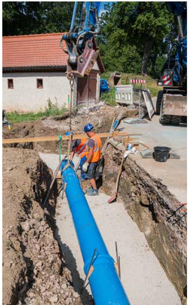
Aufgrund des geringen Eigengewichts lassen sich die HS®-Kanalrohre leicht und schnell verlegen. In Leutershausen punkteten die Produkte zudem mit ihrer Stabilität. Dadurch ist auch eine Verlegung unter geringen Überdeckungen trotz SLW 60-Belastung möglich.
