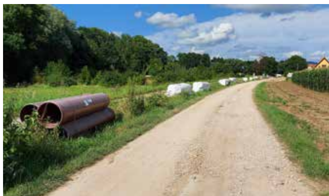
Rund 900 HS®-Kanalrohre in den Nennweiten DN/OD 315, 400 und 500 wurden vom Werk Hamm aus nach Scheßlitz geliefert.
