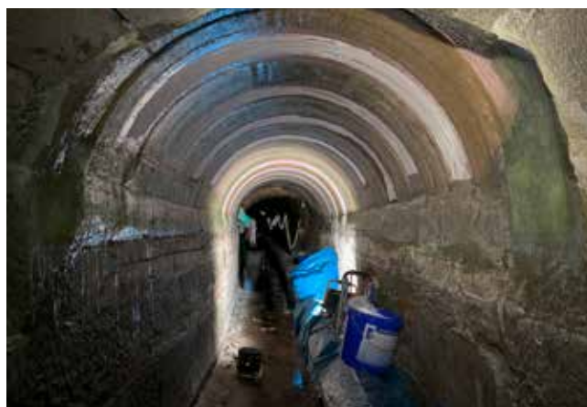
Das Laminieren der Stoßfugen zwischen den Halbschalen sorgte für die Dichtheit zwischen den einzelnen Elementen.
