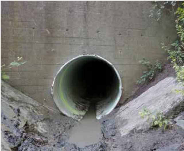
Im Sanierungsprozess: Bereits vor dem Einbau der Innendichtmanschette wird das Abwasserrohr gründlich gereinigt.
