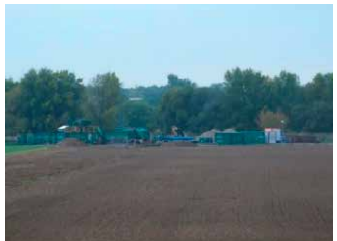
Abb. 1: Bohranlage HK 250 T mit Steuercontainer und Widerlager Beermann Bohrtechnik GmbH, Hörstel
