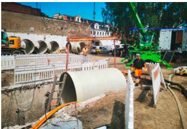
Im Vergleich zu Stahlbeton ist bei glasfaserverstärkten Kunststoffrohren auf der Baustelle kein großer Kran erforderlich.
