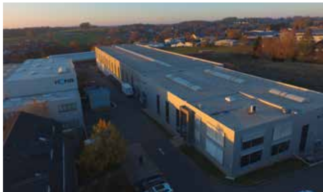
Die neue Produktionshalle am Hauptsitz in Neunkirchen-Seelscheid wurde im November 2020 fertiggestellt. Mit 6.562,5 m 2 ist sie ungefähr so groß wie ein Bundesliga-Fußballfeld.
