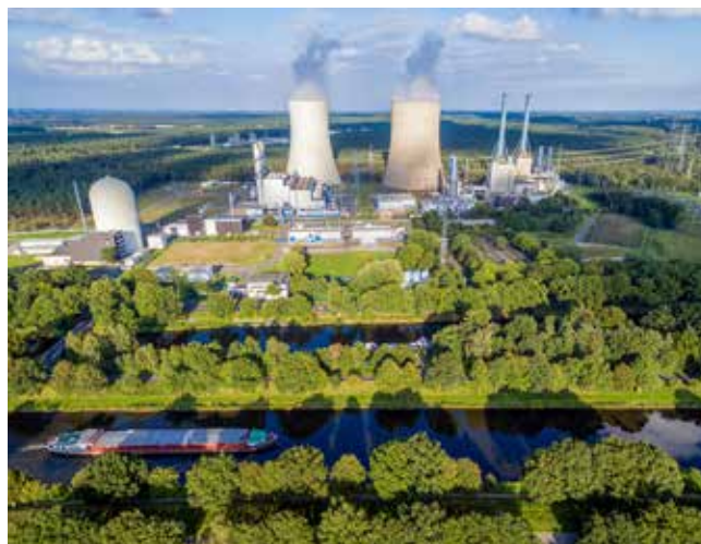
RWE Gaskraftwerk in Lingen
