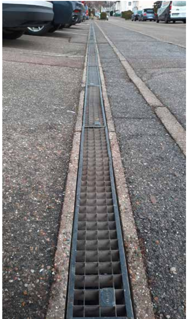
Auf dem Parkplatz eines Steinheimer Baumarkts ist der Rinnenkörper auch 40 Jahre nach dem Einbau trotz permanenter Befahrung in gutem Zustand. Aufgrund der Alterungseffekte der Gitterroste werden die Verantwortlichen im Frühjahr passende Ersatzabdeckungen montieren.
