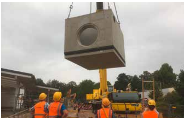
Ca. 45 Tonnen wiegt das Drosselbauwerk, das für einen geregelten Abfluss der Niederschläge sorgt. Foto: MAX BÖGL
