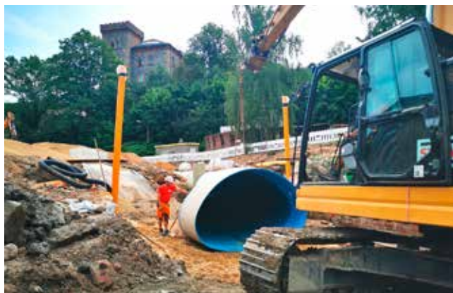
Baggertechnik ist ausreichend, um die GFK-Maulprofile 3200 x 2000 auf der Baustelle zu bewegen. Foto: Amiblu Germany
