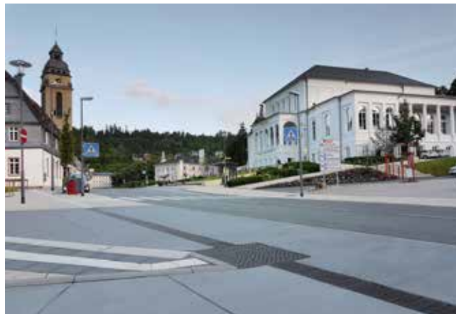
In Bad Schwalbach zieren die speziellen Gussabdeckungen das Stadtbild. Die Abdeckungen erfüllen alle sensorischen Anforderungen (visuell, akustisch, taktil) und helfen blinden oder sehbehinderten Einwohnerinnen und Einwohnern bei der Orientierung im Alltag.
