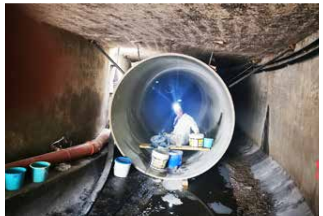
Außergewöhnlich groß ist der zu verfüllende Ringraum im Hauptkanal. Angesichts seiner Größe von 3,50 m Breite und 2,50 m Höhe wirkt selbst das GFK-Rohr DN 2200 klein. Foto: Amiblu Germany
