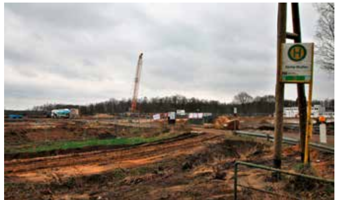
Aktuelle Baustellenfotos vom Industriepark Wulfen in Dorsten-Wulfen an der B 58.
