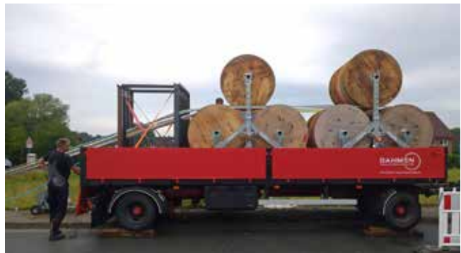
Bei der Verlegung von 300 Kilometer Lichtwellenleiterkabel trug die vertraglich fixierte Regelung eines partnerschaftlichen Miteinanders zwischen Auftraggeber und Bauunternehmen nachhaltig zu einer erfolgreichen Durchführung der gesamten Baumaßnahme bei. Foto: Dahmen Rohrleitungsbau GmbH & Co. KG
