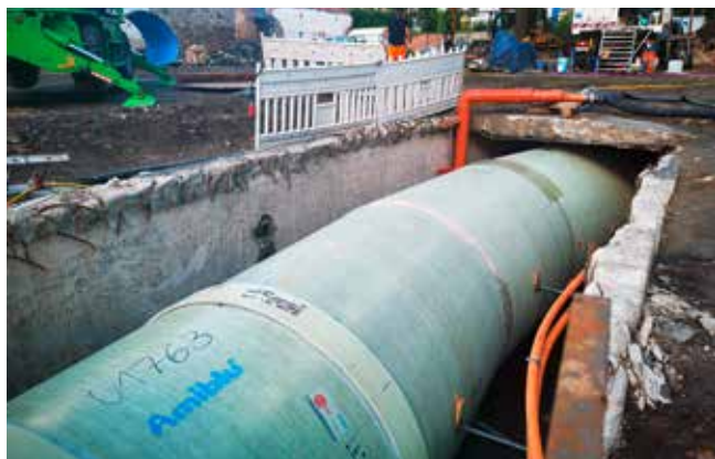
Aarsleff Rohrsanierung brachte im Görlitzer Pontekanal insgesamt 100 m GFK-Rohre der Nennweite DN 2200 per Reliningverfahren ein. Foto: Amiblu Germany
