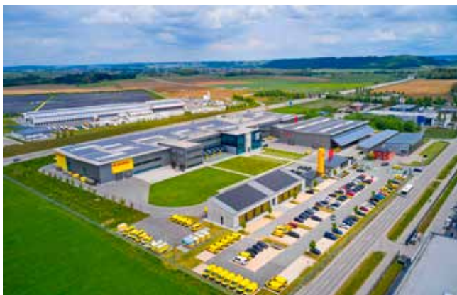
Die CO 2 -neutrale Green Factory der Alois Müller GmbH in Ungerhausen. Foto: Alois Müller
