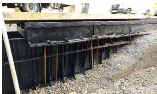
Die seitlich angebrachten Verankerungsseisen halten die Sickermulde in Position. Foto: Funke Kunststoffe
