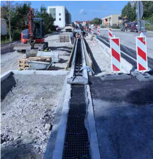
Rund 780 m D-Rainclean®-Sickermulden kamen im Erschließungsgebiet Augustenfeld-Mitte zum Einsatz. Foto: Funke Kunststoffe
