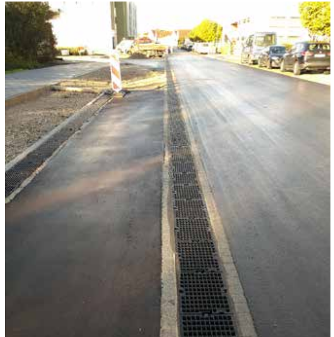
D-Rainclean®-Sickermulde mit einer Gussabdeckung der Klasse D 400 fertig eingebaut. Foto: Funke Kunststoffe
