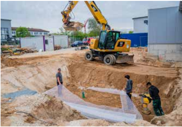
Nachdem alle erforderlichen Anschlüsse montiert sind, wird die gesamte Rigole mit Vlies ummantelt und zusätzlich mit einer Geogitterlage abgedeckt. Foto: Funke Kunststoffe
