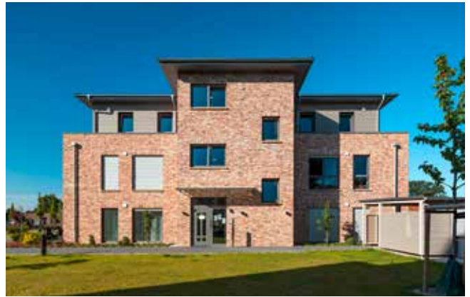
Alle Gebäude auf dem Gelände des Seniorenhofes Visbek wurden nach dem KfW-Standard 40 plus errichtet und entsprechen damit höchsten Effizienzanforderungen.
