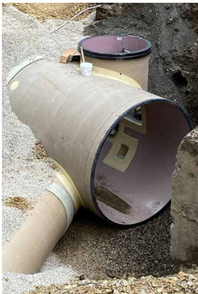
Auch die Amiblu Tangentialschächte werden aus glasfaserverstärktem, ungesättigtem Polyesterharz gefertigt und halten daher biogenen Schwefelsäuren kommunaler Abwässer sehr gut stand.
