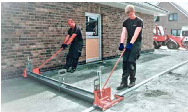
Beim Optimas Handhobel Connect sind die fünf Zwischenteile einzeln oder kombinierbar zu nutzen. Das neue Steck- und Verschlusssystem lässt stufenlose Einstellungen zu.
