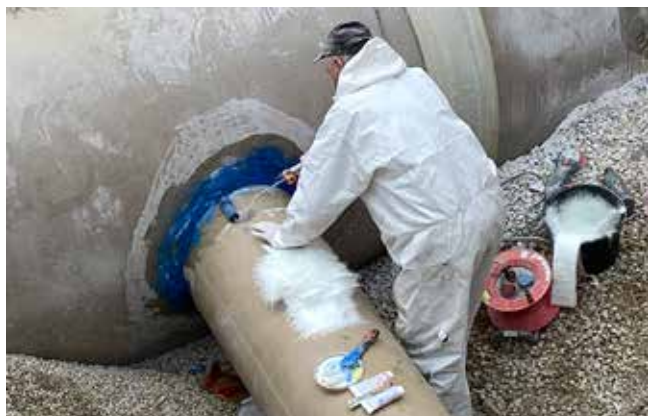
Ein Anschluss musste auf der Ringstraße nachträglich an das GFK-Kanalrohr der Nennweite DN 1800 angeschlossen werden, weil vorher die Höhe nicht klar zu bestimmen war. Für eine sichere Verbindung wurde vor Ort laminiert. Foto: Amiblu Germany GmbH
