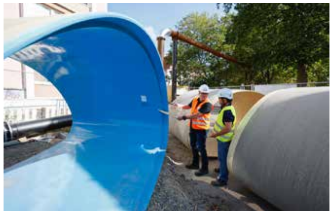
Unterschiedliche Rohrdimensionen: Güteschutz Prüflingenieur Guido Heidbrink (li.) überprüft zusammen mit Aarsleff Oberbauleiter Johannes Leewe die Wandstärke der GFK-Rohre.
