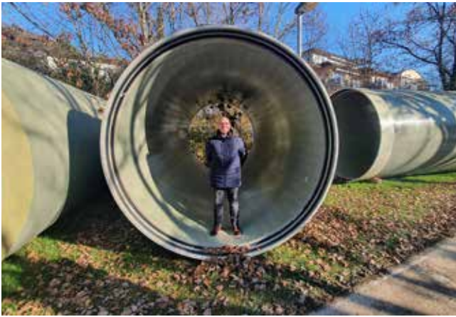
Beeindruckende Dimension: Der Stauraumkanal besteht aus GFK-Rohren DN 2600 mit je 6 Meter Länge.
