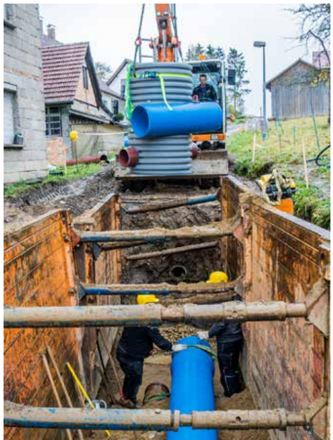
Wegen der beengten Platzverhältnisse auf der Baustelle in Laupheim kommen – neben HS®-Kanalrohren – Funke Kombischächte DN 1000 zum Einsatz. Sie erlauben in Trennsystemen die Führung von Schmutz- und Regenwasser durch ein gemeinsames Schachtbauwerk. Foto: Funke Kunststoffe GmbH
