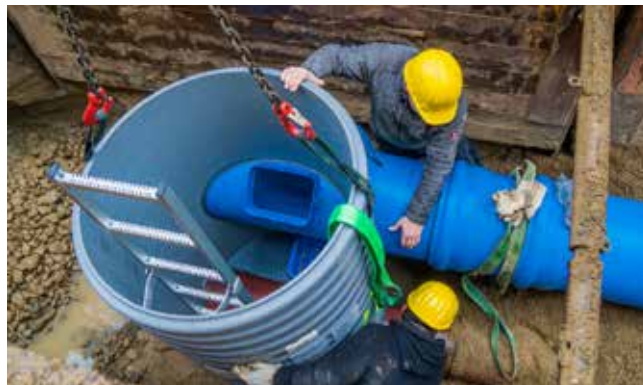
Die Funke Kombischächte DN 1000 lassen sich aufgrund ihres geringen Eigengewichtes leicht auf der Baustelle transportieren und in die Baugrube einsetzen. Foto: Funke Kunststoffe GmbH
