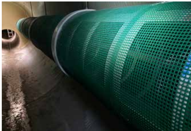
Das Amiscreen-System besteht aus GFK-Stützkörpern, die mit einem Kunststoffsitter ummantelt sind. Die Lochung des Sitters beträgt acht Millimeter. Foto: Amiblu Germany GmbH
