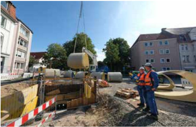
Die GFK-Rohre werden mit einem Kran in die Baugrube abgelassen und von dort mit einem speziellen Fahrwagen in die Lutter-Verrohrung eingefahren. Alexander Garen (Umweltbetrieb der Stadt Bielefeld, rechts) und Prüflingenieur Guido Heidbrink (Güteschutz Kanalbau, links) besprechen den Sanierungsfortschritt.
