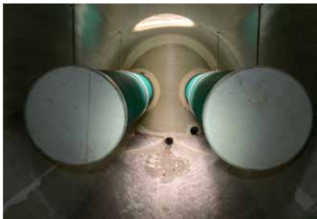
Über die beiden je vier Meter langen Amiscreen-Rohre gelangt das von Schmutzstoffen befreite Wasser in den untenliegenden Klärüberlauf. In der Mitte ist die Öffnung zu sehen, über den der Trockenwetterabfluss abgeleitet wird. Rechts daneben liegt der Abfluss in den Drosselschacht. Foto: Amiblu Germany GmbH
